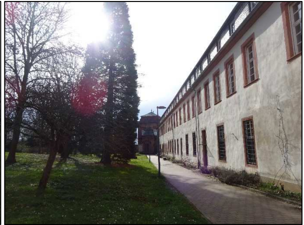
Blick auf das südlich Plangebiet, entlang des Haus St. Gottfried.
