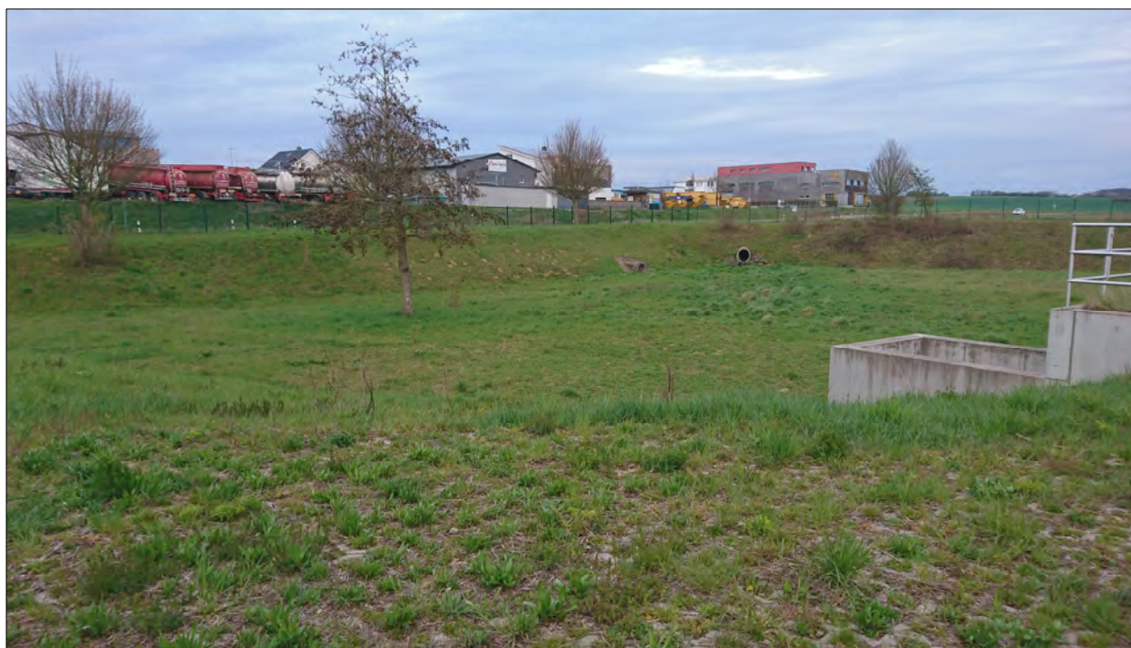
Abbildung 14: Blick von Nordwesten in das Regenrückhaltebecken. Foto: IBU 2021
