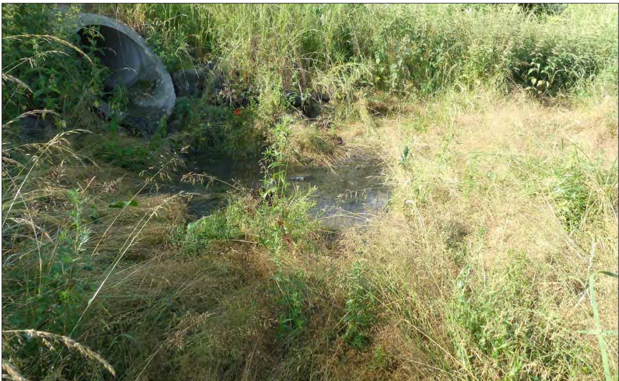
Abbildung 6: Das Temporärgewässer im Regenrückhaltebecken bietet Amphibien keine Reproduktionsmöglichkeit (Foto: IBU, 18.06.2021).
