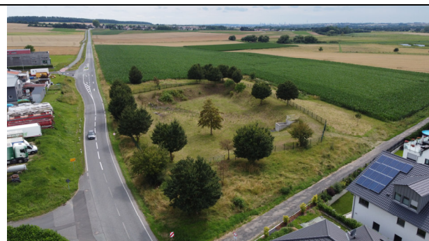
Abb. 7: Regenrückhaltebecken und Burg-Gräfenröder Straße
