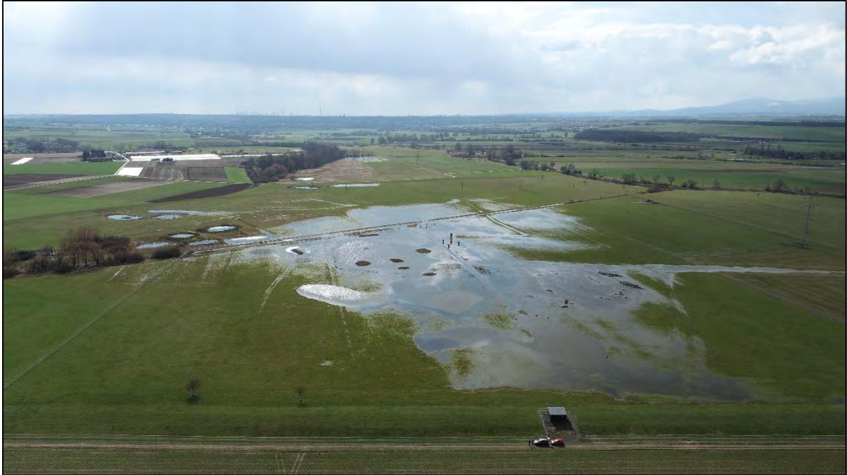
Abbildung 9: Blick auf vernässten Grünlandbereiche des VSG „Wetterau“. Der Weg am unteren Bildrand wird zurückgebaut. Gut erkennbar sind auch der daran anschließende Damm und die Umzäunung der Teilfläche.
