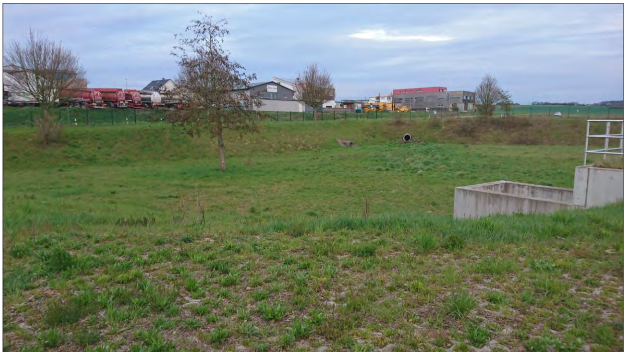
Abbildung 19: Blick von Nordwesten in das Regenrückhaltebecken. Foto: IBU 2021
