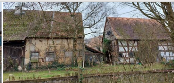
Werkstatt und Scheune im östlichen Bereich
