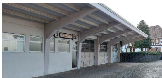
Feuerwehr-Gerätehaus in Assenheim
