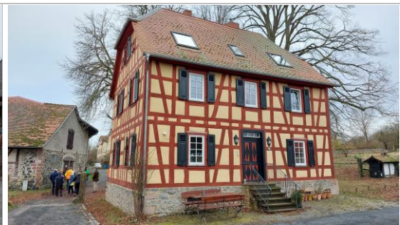
Saniertes Gebäude in Wickstadt
