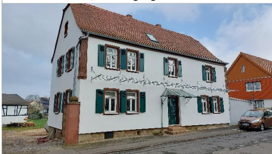
Erbstädter Str. 26, Spätbarockes Fachwerkwohngebäude (Kulturdenkmal)
