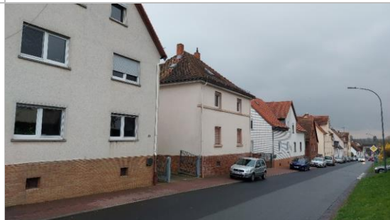
Altenstädter Str. (Höhe Nr. 25, Richtung Süden)
