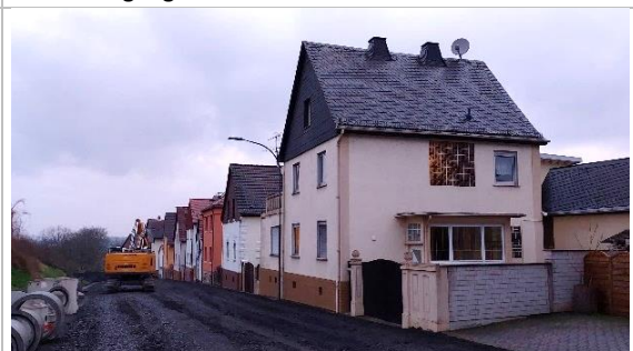
Gebäude Assenheimer Str. 31 - 45
